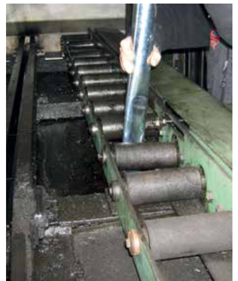
Aspiration de boues sur rectifieuses
